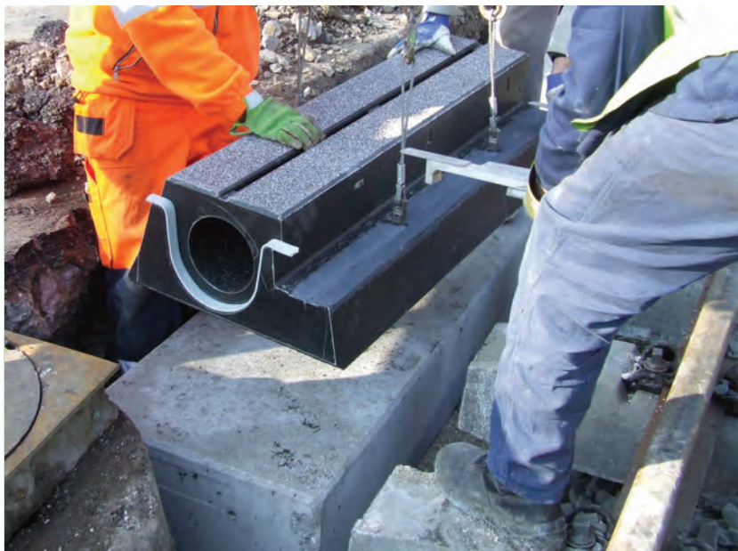
2. ábra. S-BORD résfolyókaelem
