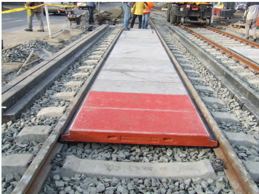
4. ábra. Épülő villamosátjáró a Maglódi úton
